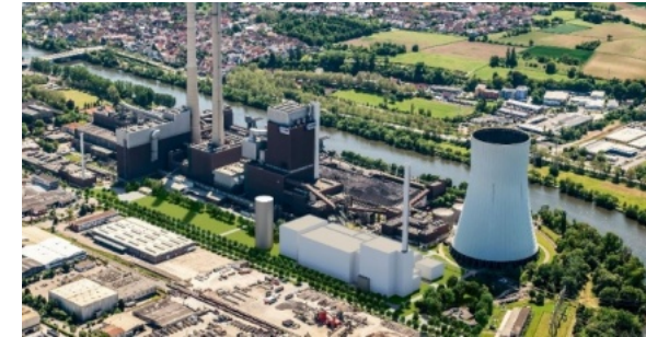
GuD-Anlage mit 675 MW el und bis zu 190 MW Wärmeauskopplung. Stilllegung Kohleblock HLB7 mit 778 MW el .
