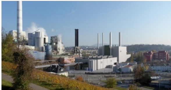
Gasturbinenanlage mit 124 MW el und Abhitzedampferzeuger. Stilllegung Kohlekessel und Gasturbinen.
