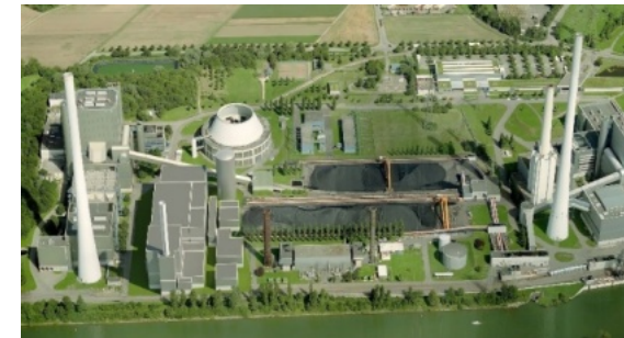
GuD-Anlage mit 665 MW el und bis zu 180 MW Wärmeauskopplung. Stilllegung Kombiblock HKW 2 mit 401 MW el .
